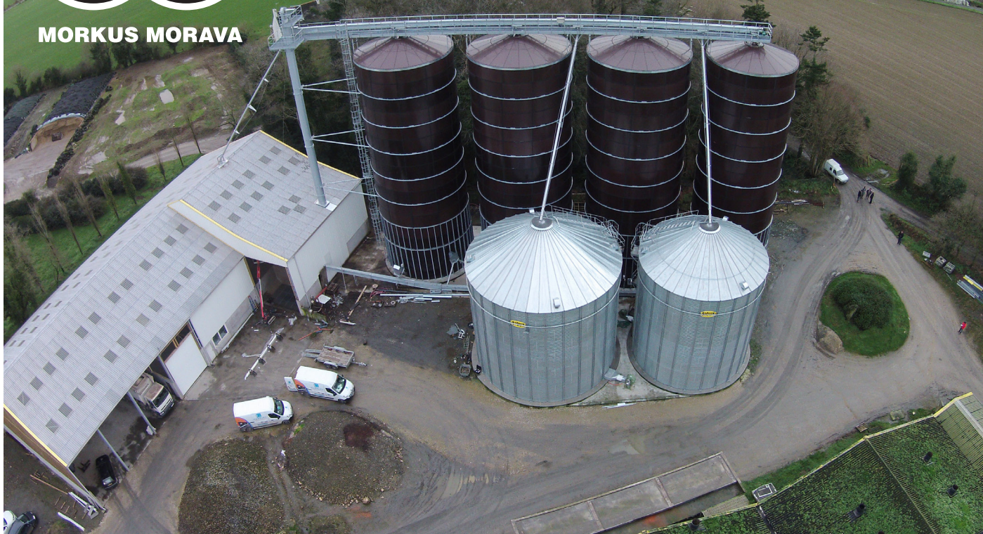
Obr. 1: Pohled na věžové zásobníky pro skladování v ochranné atmosféře cO2 s navazující výrobní krmných směsí
