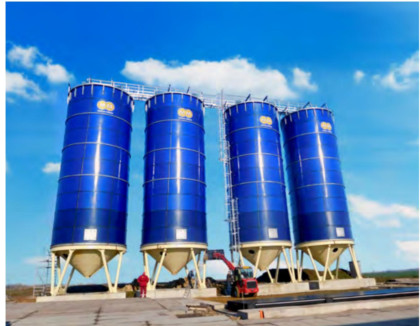
Sila na vlhkou kukuřici vycházejí z typové řady obilních sil a mají speciální systém vybírání vlhkého zrna. Smaltovaná sila na vlhkou kukuřici jsou určená ke skladování vlhké kukuřice sklízené přímo z pole ve stádiu mléčné zralosti. Kukuřice je ve smaltovaném silu konzervována kyselinou mléčnou, která
