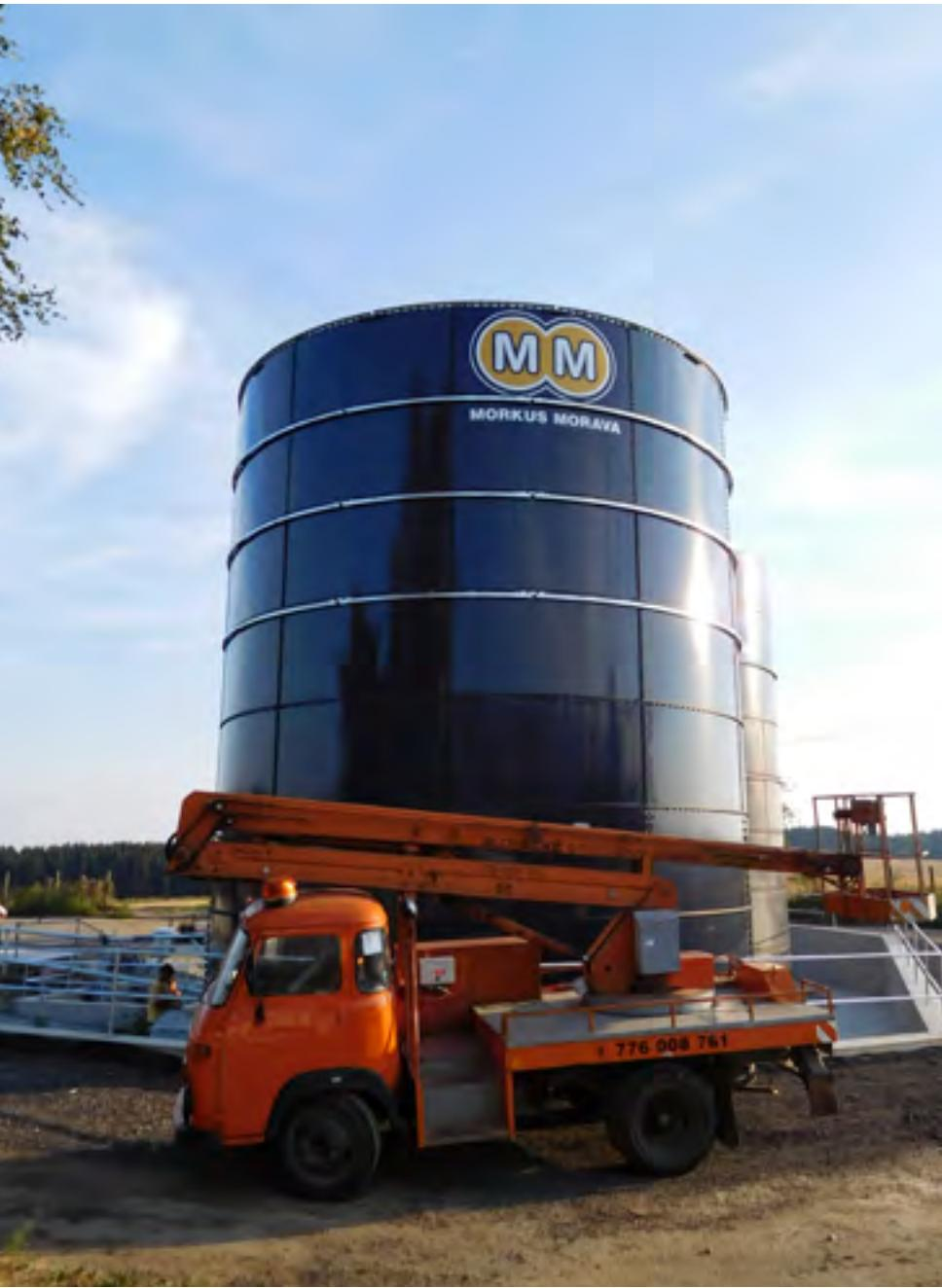
Nádrže na kejdu ze smaltovaných plechů slouží pro uskladnění kejdy a odpadních vod z objektů živočišné výroby. Zajišťujeme a realizujeme celkové návrhy řešení až po komplexní realizaci, tj. skladové a přečerpávací nádrže, včetně technologického vybavení čerpání, potrubních rozvodů, míchání a vyskladňování.
