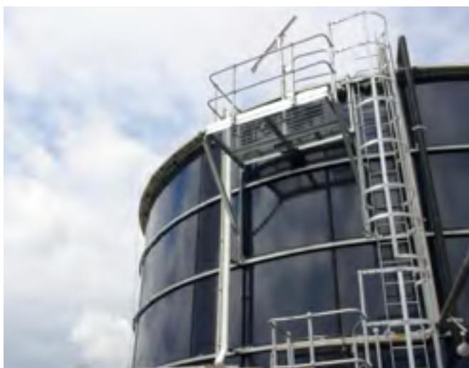
Nádrže na kejdu nabízíme jak ve variantě otevřené, tak se střechou. Nádrže jsou vybaveny kotvením, ocelovým či betonovým dnem, výztužnými úhelníky, revizním otvorem, žebříky, přepadovým potrubím, výpustným hrdlem, plo-
