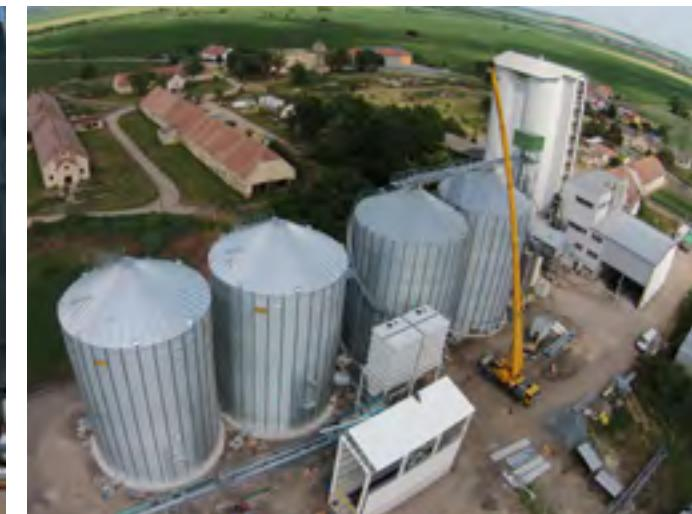
Pozinkovaná obilní sila jsou našim zákazníkům dostupná od průměru 4,57 m až do průměru 32 m. Používáme výhradně vysoko kvalitní pozinkovaná sila s vlnitým plechem se sílou vrstvy ve standardu G-115 (350 gr/m<sup>2</sup>), což je o 25% silnější
